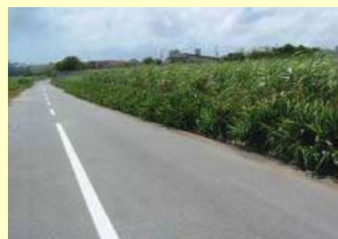
グリーンベルト設置
