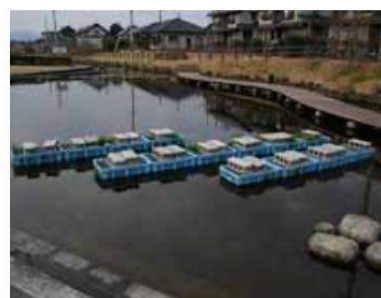
木炭浄化（接触酸化法の一つ）
